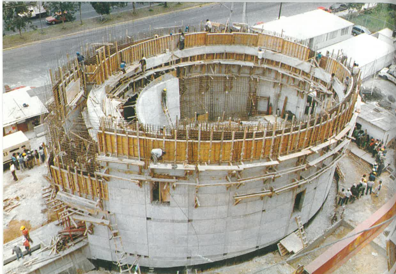
Panorámica de la construcción del salón de sesiones.
