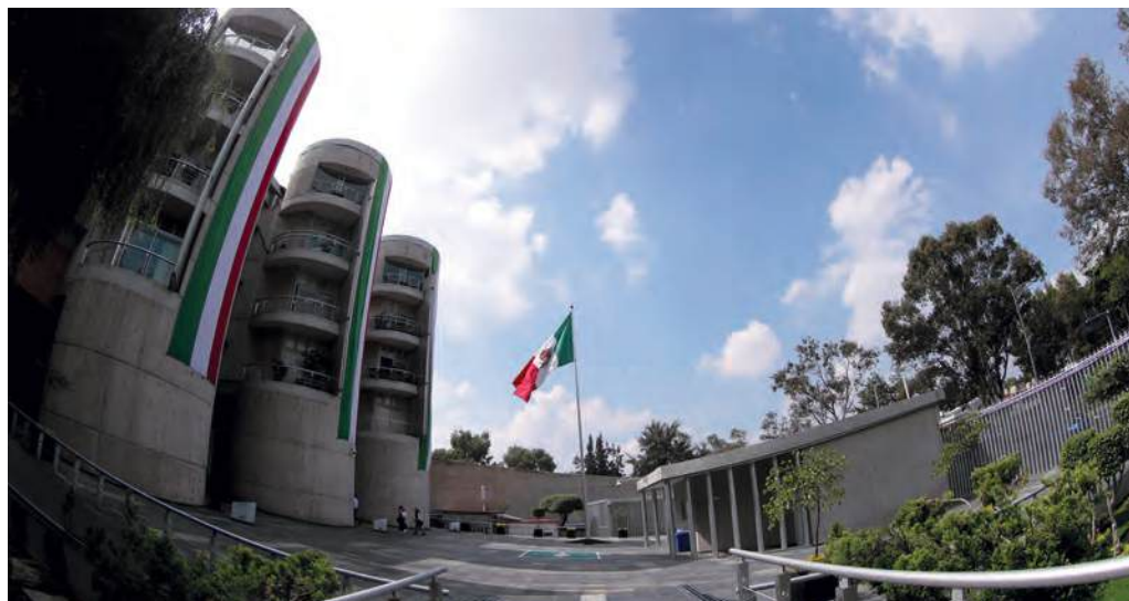
Explanada central, edificio sede del Tribunal Electoral del Poder Judicial de la Federación.
