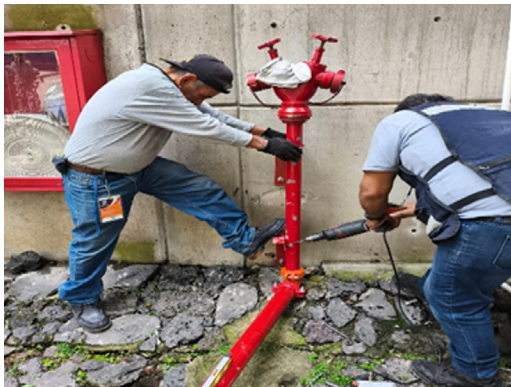
Instalación de 6 nuevas secciones de tubería expuesta del sistema de supresión contra incendio a base agua en el inmueble de Sala Superior. Dirección General de Protección Institucional.
