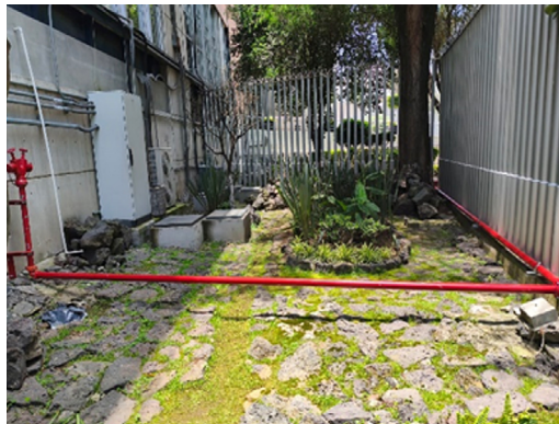
Instalación de 6 nuevas secciones de tubería expuesta del sistema de supresión contra incendio a base agua en el inmueble de Sala Superior. Dirección General de Protección Institucional.
