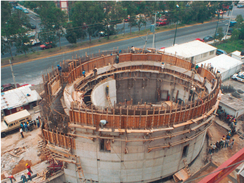
Construcción del salón de plenos de la Sala Superior del Tribunal Electoral del Poder Judicial de la Federación, 1993.
