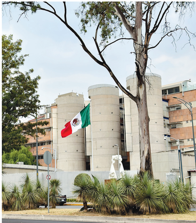
Edificio principal de la Sala Superior del Tribunal Electoral del Poder Judicial de la Federación, 2025.
