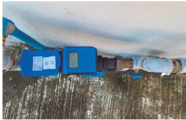
Cambio de los 2 medidores electrónicos instalados por la Cmas.
