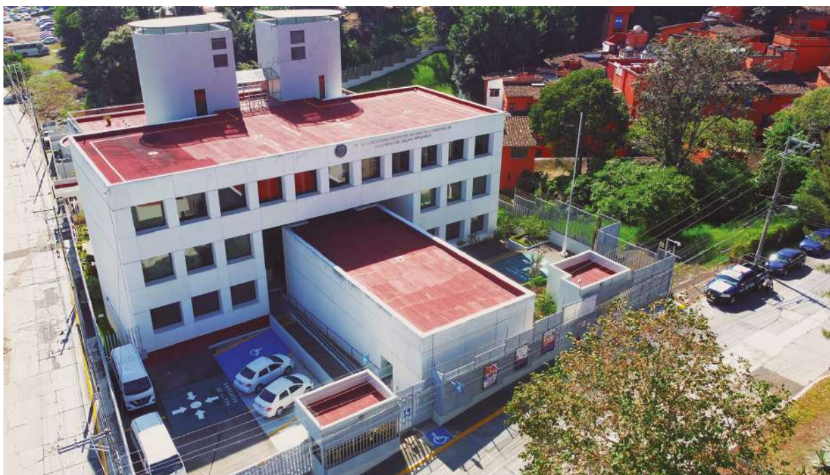
Instalaciones de la Sala Regional Xalapa.
