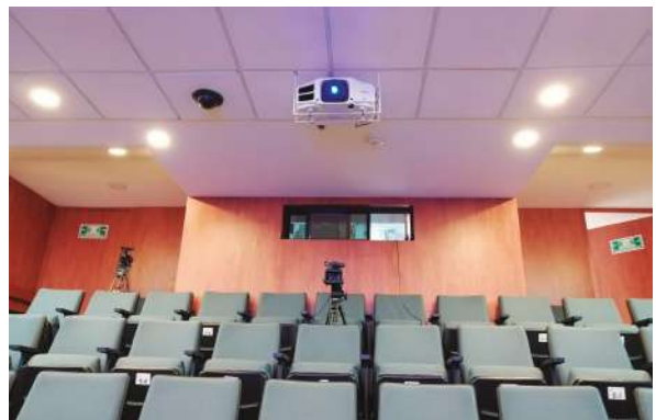
Equipos de transmisiones ubicados en el salón de plenos de la Sala Regional.
