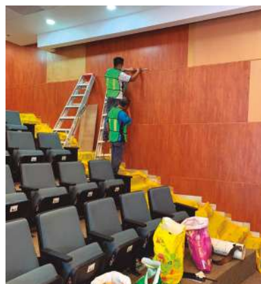
Instalación de láminas color madera.
