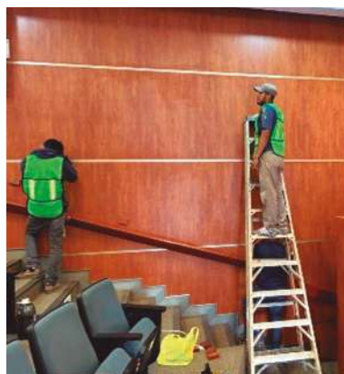
Forro del pleno.
