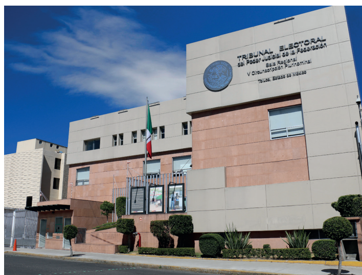
Fachada de la Sala Regional Toluca.
