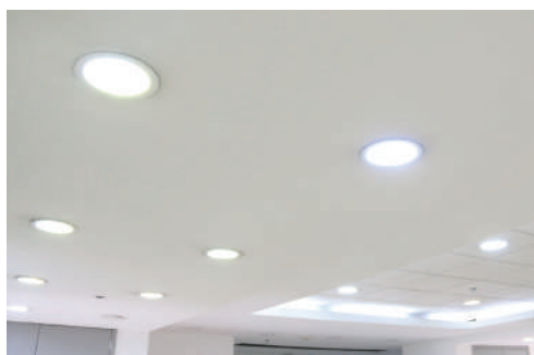
Cambio de lámparas PI 26 por led.
