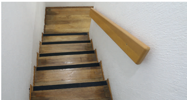
Acceso al antepeno por el cuarto piso.
