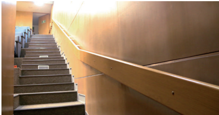
Barandal instalado a un costado del Salón de Plenos.
