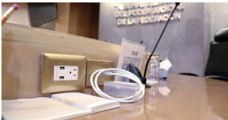
Conexiones en los espacios de los magistrados.
